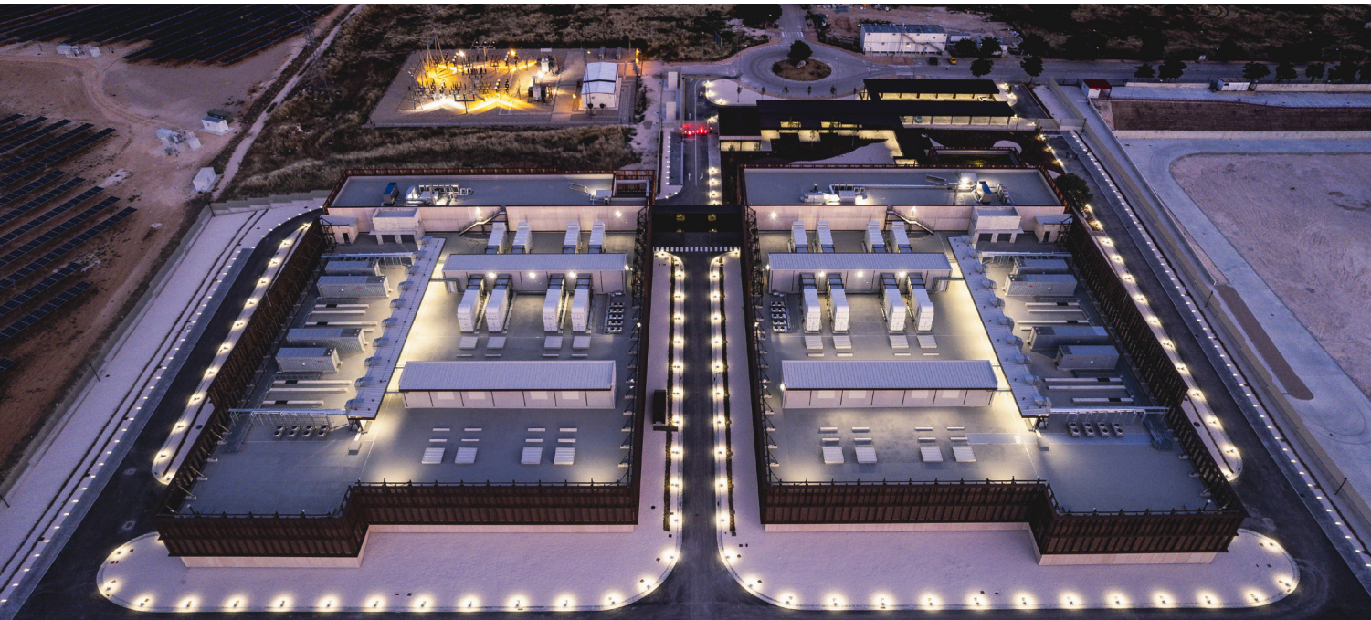
Data processing centre executed by FCC Construcción.
